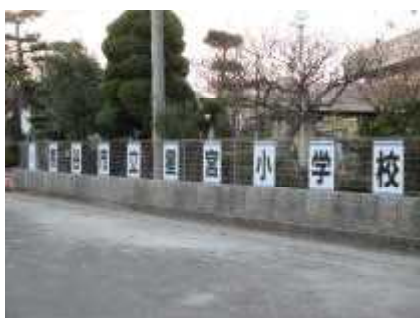
11/29(木)正門側フェンス完成
