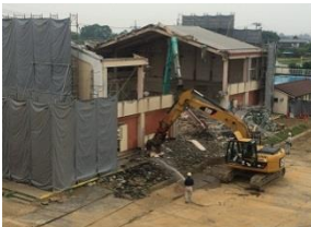
6/18 旧体育館解体中
