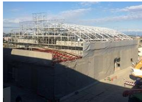
12/25 新体育館屋根骨組完成
