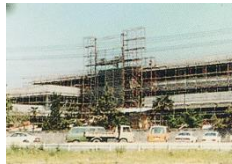
《新校舎建設中》
